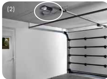
Exemple d'installation de la commande duo vision : montage à l'arrière (1), en haut (2) et devant (3)
